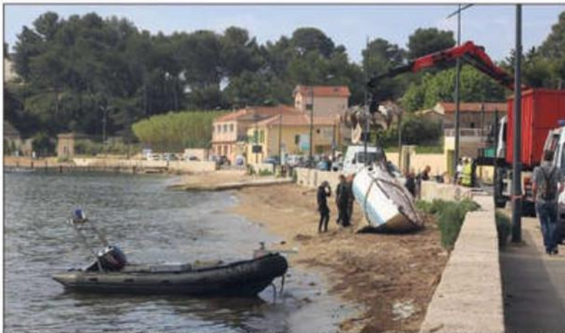
L'opération est le fruit d'une collaboration entre la Marine nationale et la Ville de La Seyne qui, outre la partie administrative, a passé un marché auprès d'une entreprise pour l'enlèvement et la destruction des épaves.
